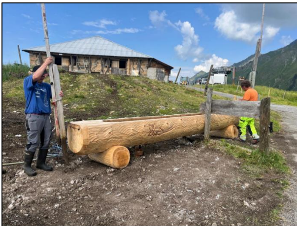
Remplacement du bassin de la Marnèche
