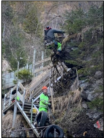
Purge du sentier du Torrent d'Ayerne
