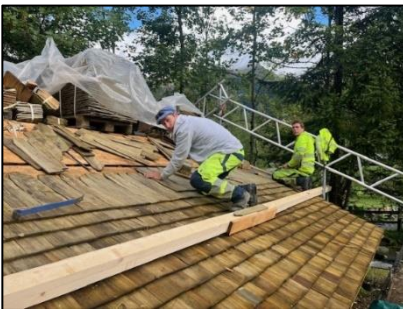
Rénovation de la toiture des sanitaires
