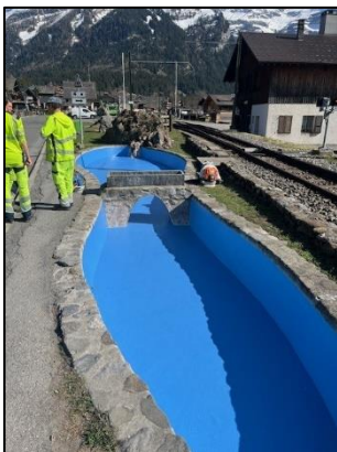
Rénovation de l'étanchéité du bassin de la marmotte
