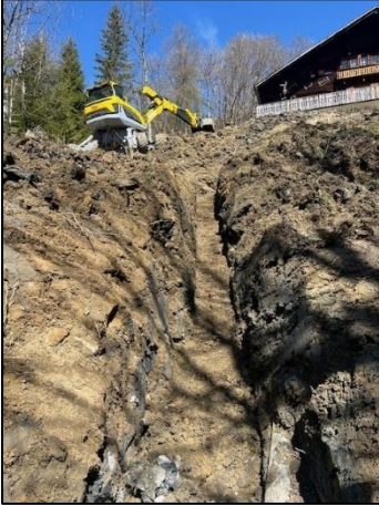
Remplacement de 40 m. de conduites au-dessus du chemin de la Coutaz
