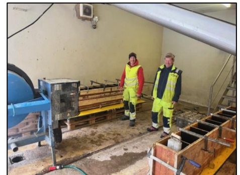
Travaux de maçonnerie à l'atelier des Aviolsats
