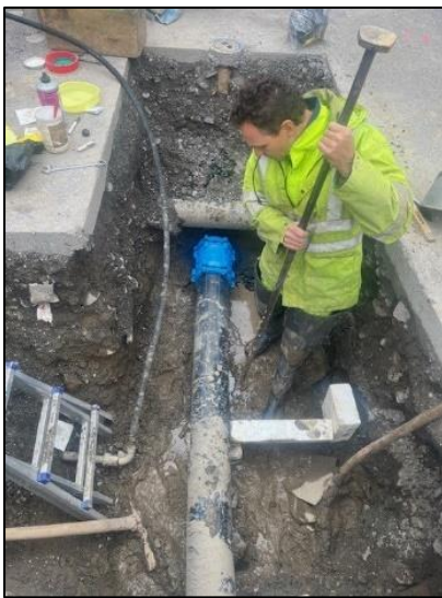
Travaux de réfection au chemin du Creux
