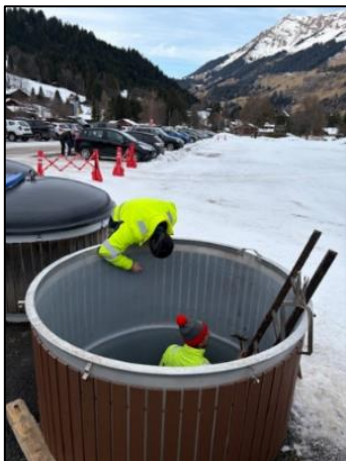
Remplacement de l'habillage en bois d'un molok
