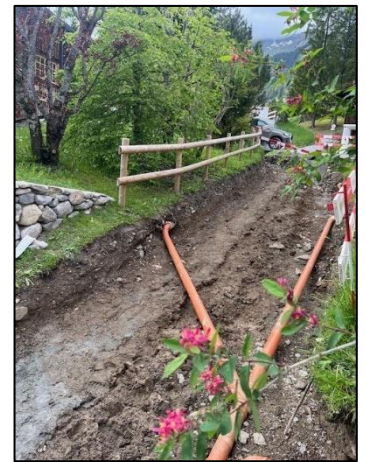
Remplacement de 100 m. de conduites au Plan Fromentin
