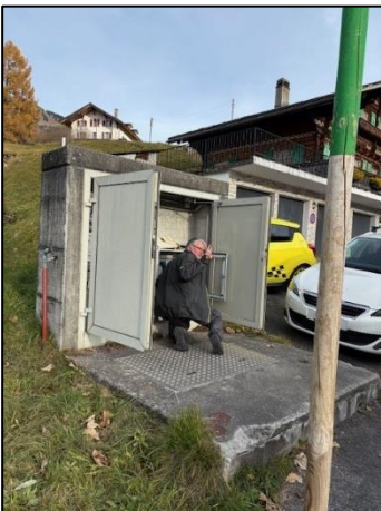
Remplacement d'un modem 3G par un modem 5G
