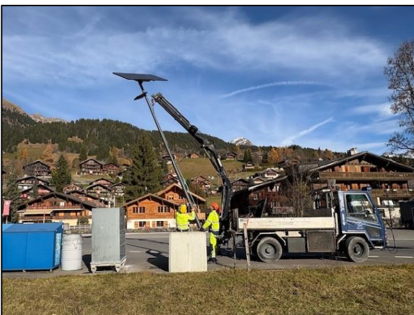
Manutention d'un mât d'éclairage
