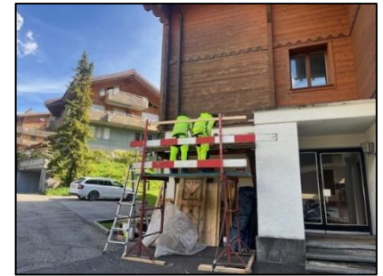
Réfection du porche côté Nord-Ouest du bâtiment de l'Office du Tourisme
