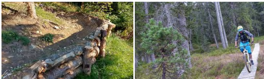
Figure 5. Exemple d'une stabilisation bien intégrée d'une piste VTT à Leysin et d'une passerelle permettant de canaliser les VTT au niveau de la traversée d'une zone marécageuse (la tourbière - Pointe de Puvat - Les Glières)
