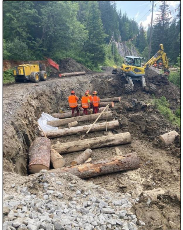
*Construction d'un caisson de soutènement dans le cadre d'un cours de formation pour les apprentis forestiers-bûcherons à La Bierle*
