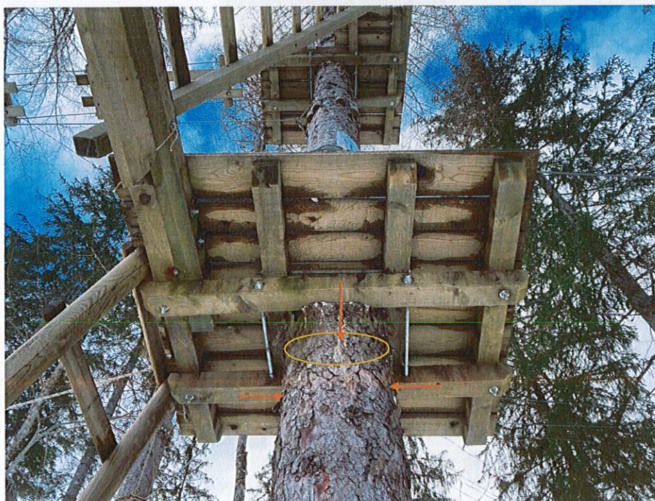
Photo 5: La plateforme en bois blesse l'arbre, ce qui empêche la circulation de la sève sur plus de 70% du diamètre du tronc et affaiblit fortement l'arbre. Cela le rend plus sensible aux attaques de bostryche. La plateforme aurait dû être adaptée régulièrement à la croissance de l'arbre, ceci depuis plusieurs années.
