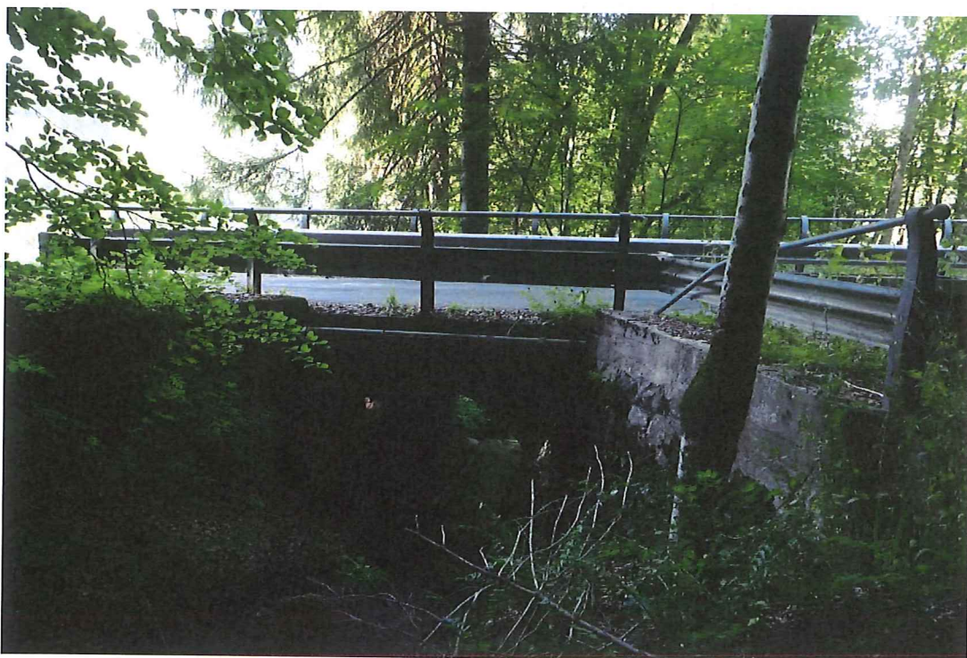
Figure 4 : Pont sur la route des Voëttes où l'avalanche pourrait sortir du lit du torrent.
