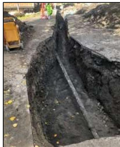
À la mi-octobre, une fuite sous la terrasse du chalet en bas de La Cottettaz nous a obligé à déplacer la conduite. La voirie a pris en charge les travaux de génie civil, de la pose et du raccordement de ladite conduite.
